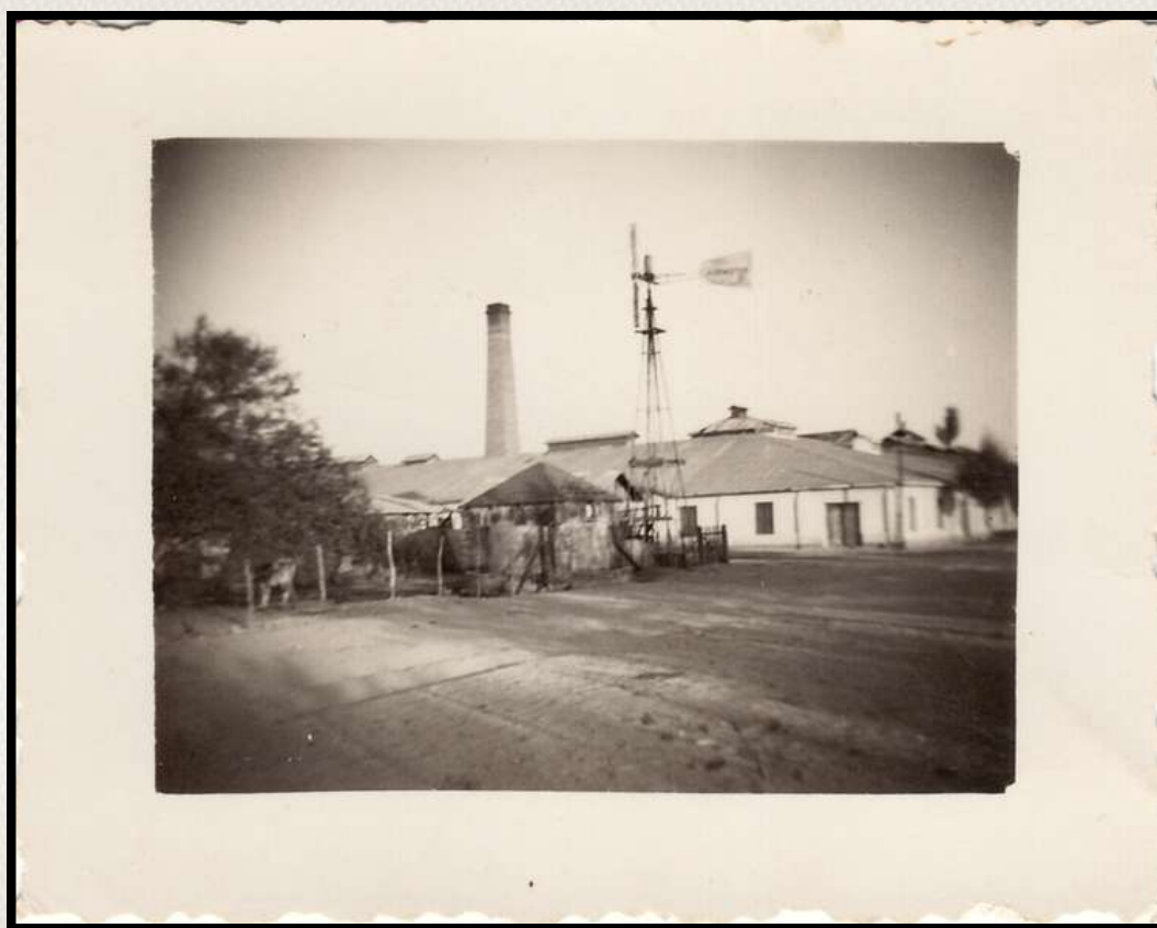
*Vista a la Tenería Suela Viosca.
